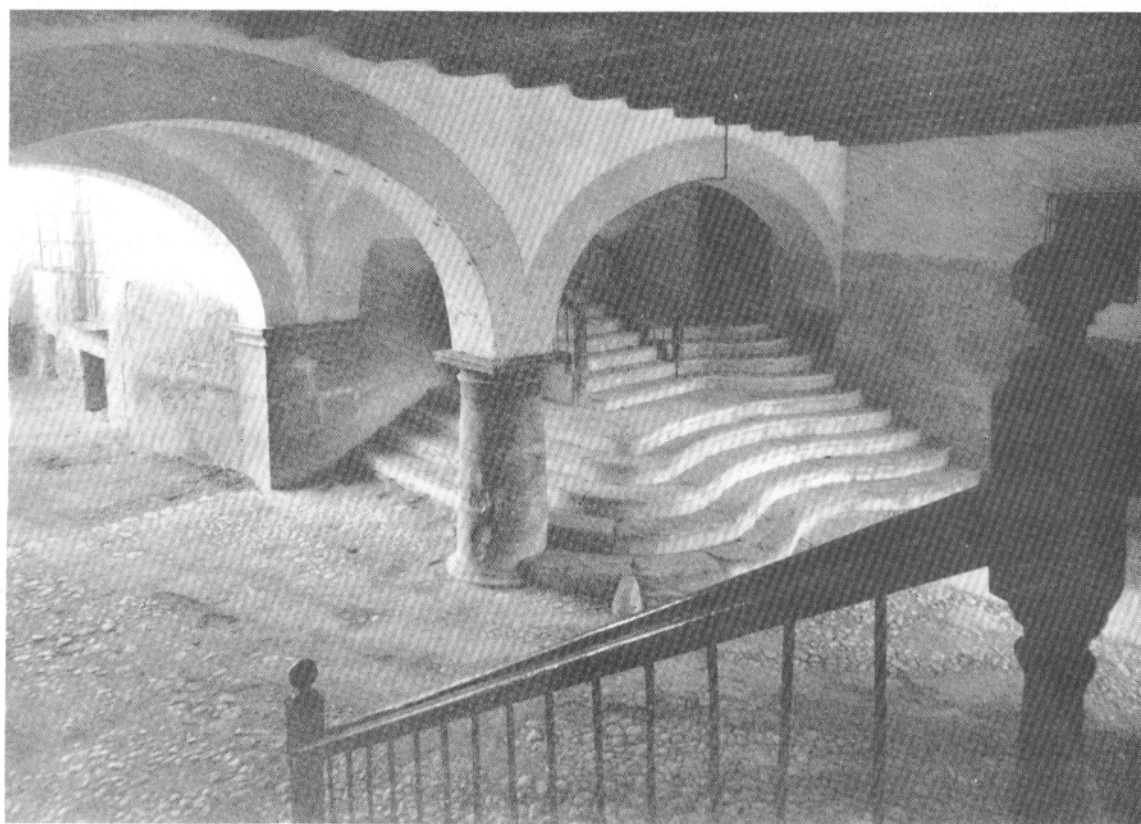
Foto de la desaparecida Casa del Paso.
